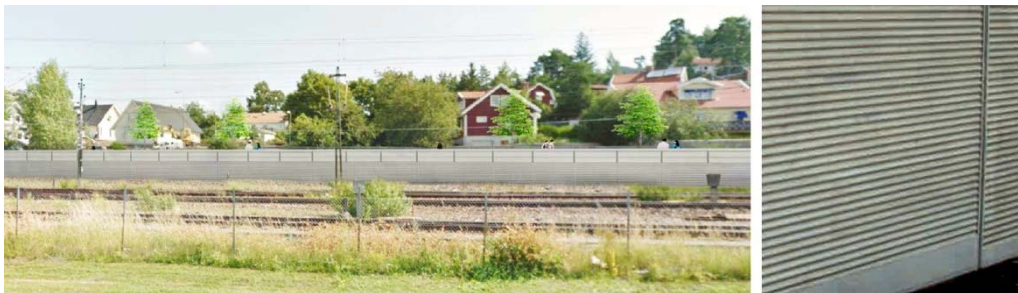
Vy från Bromstensvägen mot Solhemsbackarna samt exempel på betongyta med sinusmatrismönstrad yta, Trafikverket
