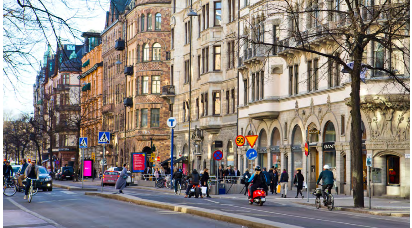
Birger Jarlsgatan, stadens äldsta affärsgata, byggd efter kontinentalt mönster i slutet av 1800-talet.
