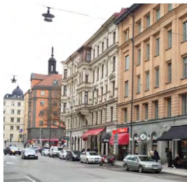
Förhöjd bottenvåning med lokaler, en vanlig lösning i stenstaden. Bilden visar Tegnérgatan. Fotograf: Davdi Essinger
