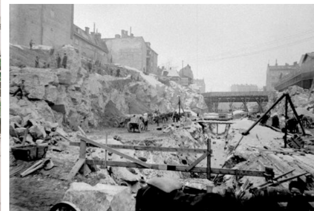
Byggande av Kungsgatan, år 1909. Fotot är taget i korsningen med Norrlandsgatan, Regeringsgatan på bro syns i fonden.
