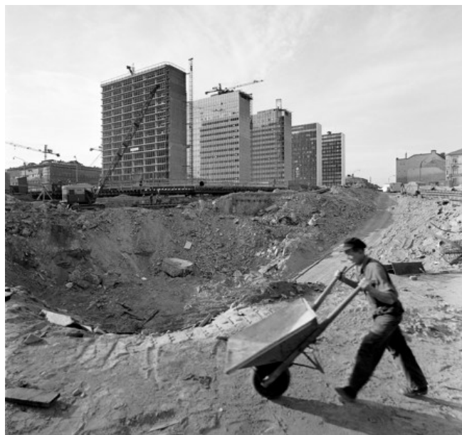
Brunkebergsåsen schaktas bort. Gropen vid Malmkillnadsgatan/Hamngatan, år 1961. Källa: Stadsmuseet
