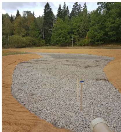
Del av dagvattenanläggningen i Prästängen under utförande.
