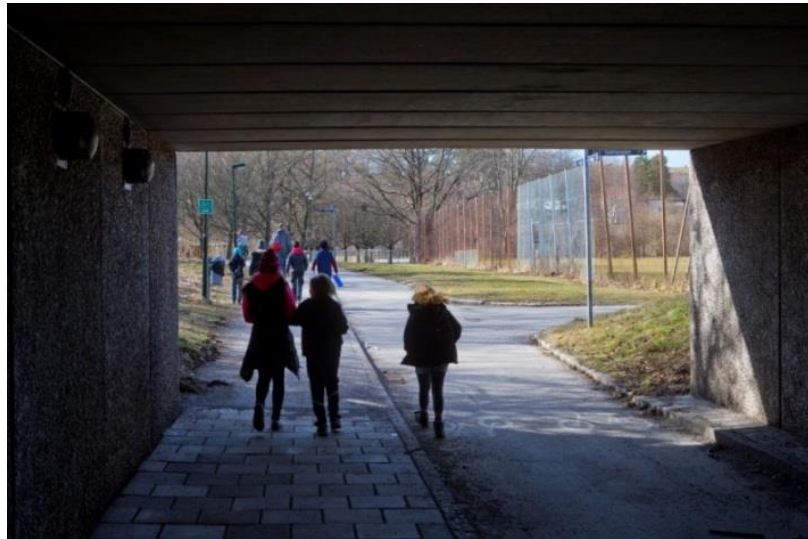
Gångtunnel i Farsta 2015. Gångtunnlar upplevs ofta som otrygga och det är därför extra viktigt med gestaltningen och belysningen av dessa. Fotograf: Lennart Johansson.
