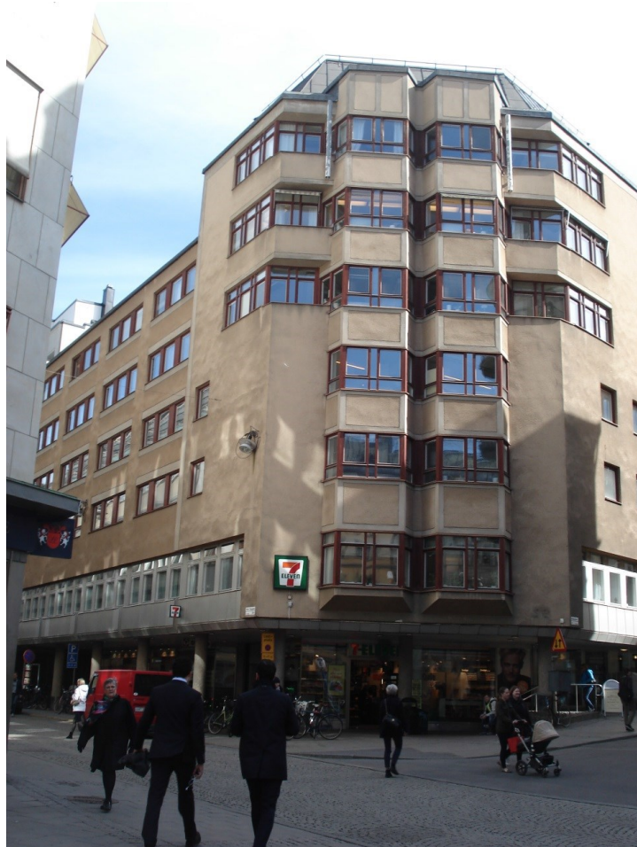
Befintlig fasad sedd från Birger Jarlsgatan
