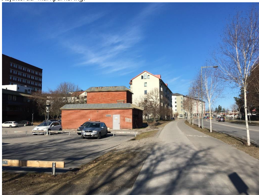
Befintlig bebyggelse. Sopsugsanläggning i tegel på parkeringen invid Fruängsgårdens servicehus, vy mot Vantörsvägen. Cykelväg och gångstråk. Lameller i ljus puts i 5 våningar i fonden., vilka är hyresrätter som ägs av Familjebostäder. Ännu längre bort lameller i vit och grön puts.
