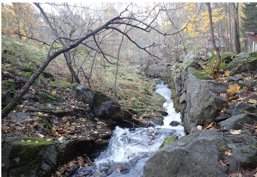
Figur 32. Nedströms den nya naturliknande fiskvägen förbättras förutsättningarna för fiskvandring genom bottenuppbyggnad och biotopvård. Norconsult 2016.
