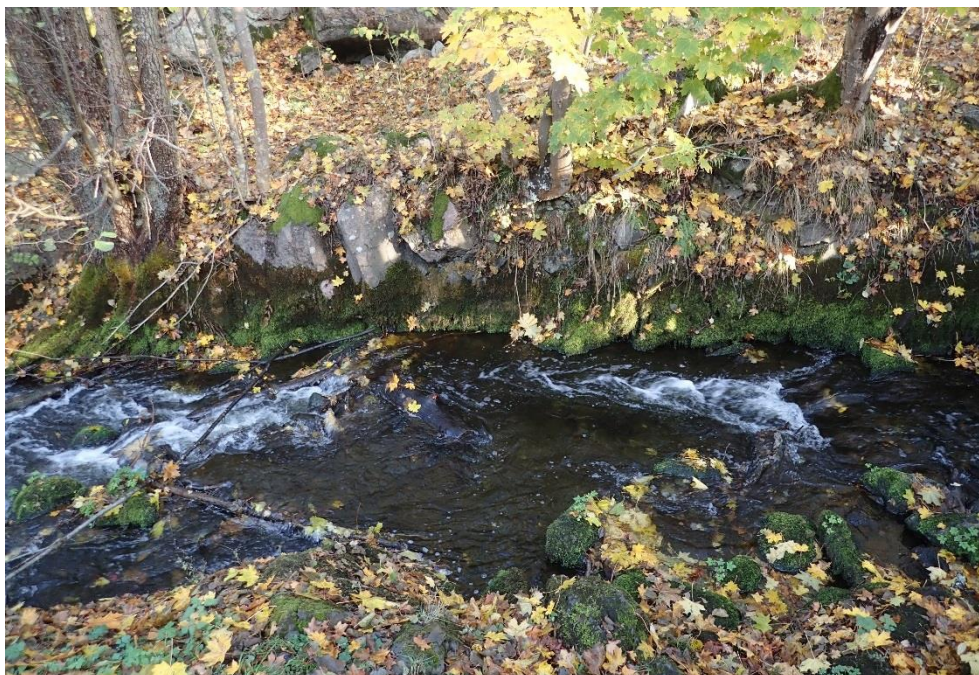
Figur 27. Nedströms utskovet vid Kvarndammen är fåran sprängd. Norconsult 2016.
