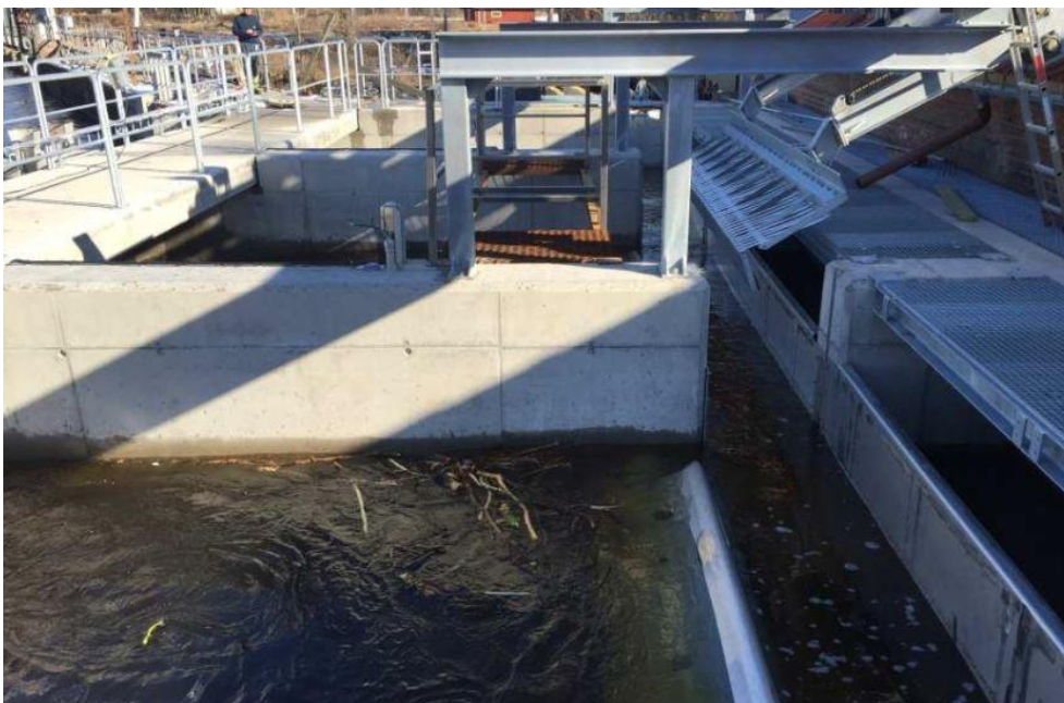
Figur 34. Exempel på alfagrind med flykträna vid Västerkvarns krv i Kolbäckån.
