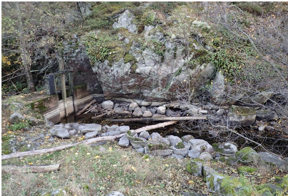
Figur 25. Kronddammen belägen i det vänstra utloppet av sjön Tyresö-Flaten. Tidigare fanns ett skibord till vänster om befintlig dammbyggnad. Norconsult, 27 oktober 2016.
