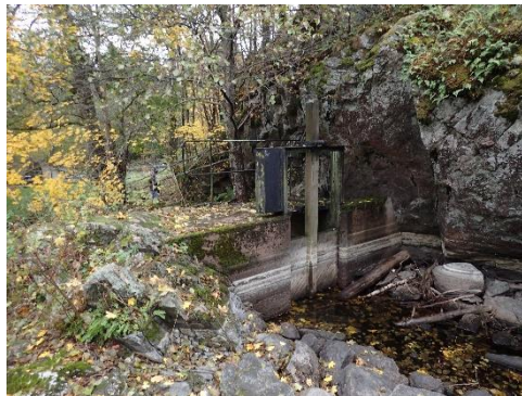
Figur 16. Krondammen vid Nyfors. Norconsult 2016.
