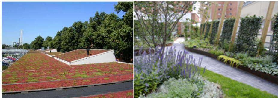
Figur 5. Gröna tak med olika karaktär och fördröjningsförmåga
