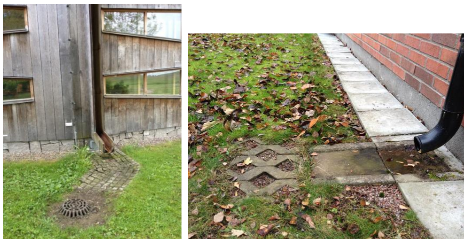
Figur 6. Utkastare till dagvattenbrunn respektive infiltration.
