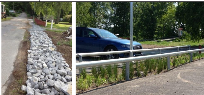
Figur 10. Krossmaterial/ grönyta som kan läggas vid parkeringsytor.
