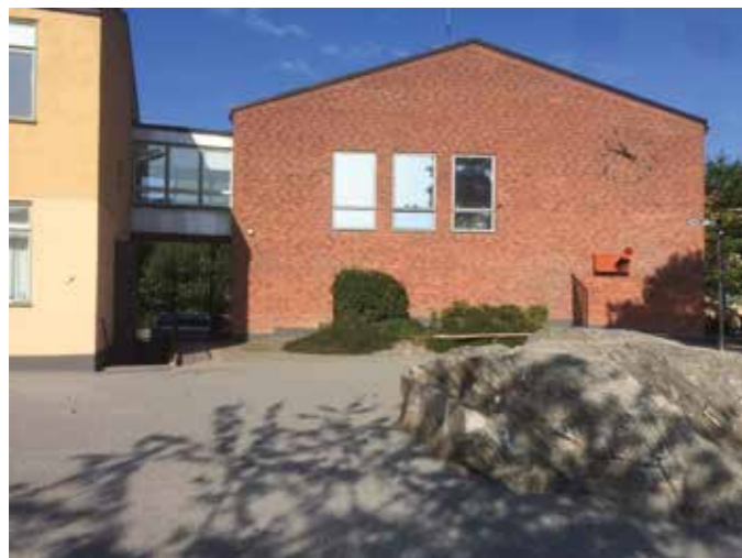
Befintlig tegelfasad Hus B.
