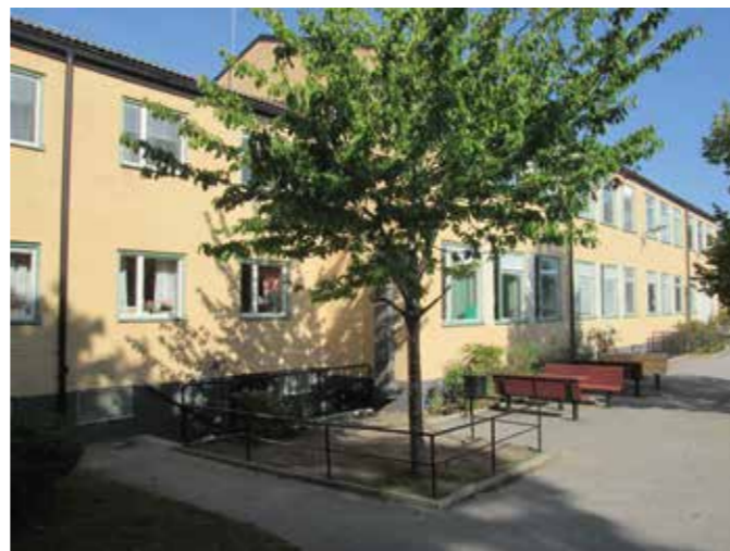
Befintlig gulputsad fasad Hus A, D och C.
