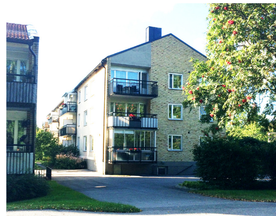
Befintlig 50-talsbebyggelse i anslutning till parkens norra del, 3 våningar
