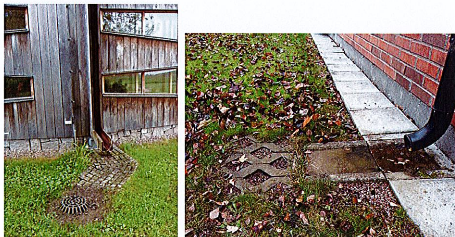
Figur 6. Utkastare till dagvattenbrunn respektive infiltration.
