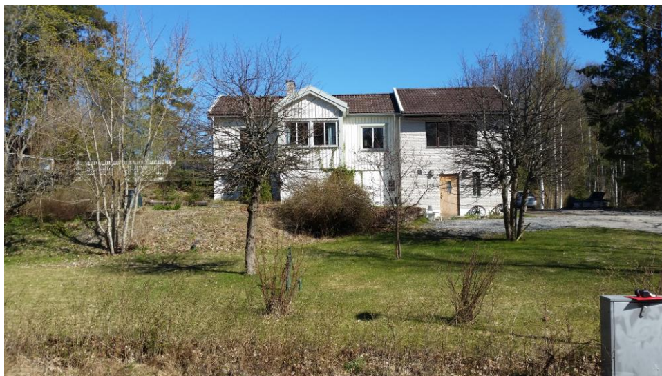
Fotot visar den befintliga bmvudbyggnaden på fastigheten Strand 1:120
