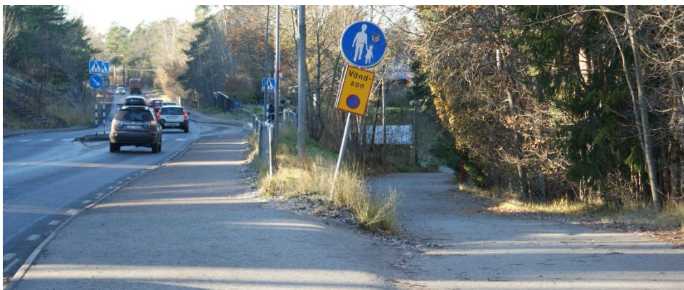
Ont om utrymme längs med väg 247 Skärgårdsvägen och otydligt var cykelvägen går
