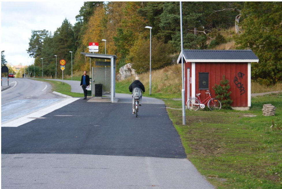
Cykelbana bakom busshållplats i Värmdö, Skärgårdsvägen
