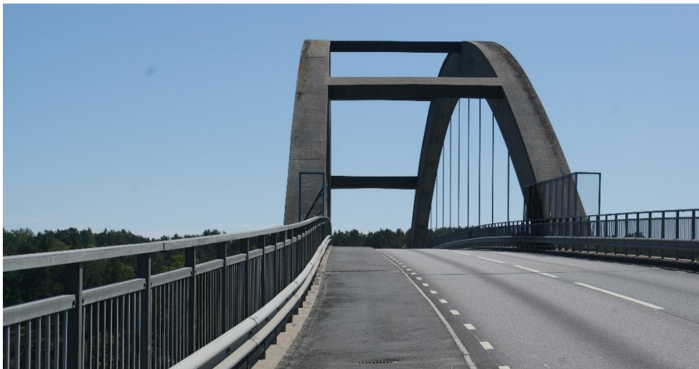
Gång- och cykelväg över Djuröbron
