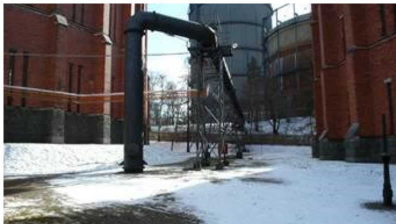
Bild 1 – gasledningens sträckning mellan gasklockorna och över Gasverksvägen
