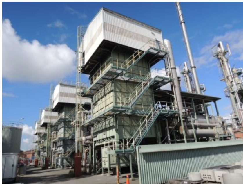
Bild 2 – I förgrunden en av fyra spaltugnar. Denna spaltugn skulle kunna sparas och förses med en ny trappa som funktion.
