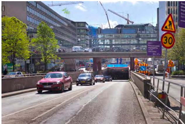
Sveavägen med nedfarten till Klaratunneln
