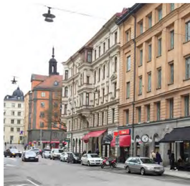
Förhöjd bottenvåning med lokaler, en vanlig lösning i stenstaden. Bilden visar Tegnérgatan. Fotograf: David Essinger
