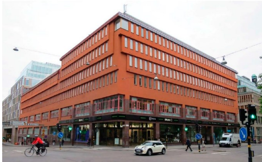
Befintlig byggnad (foto: Nyréns)
