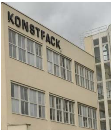
Den ursprungliga fabriksbyggnaden har en strikt repetitiv fönstersättning
