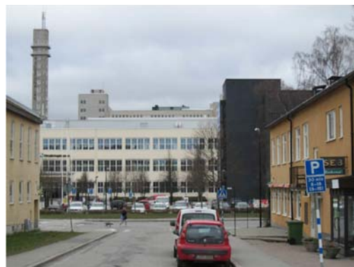
Foto som återspeglar LM Ericssons expansion under efterkrigstiden; Den ursprungliga fabriksbyggnaden med senare tillkommet radiotorn och kontorsbebyggelse, smalhusbebyggelse till höger, Midsommargårdens flygel till vänster och Designens hus högdel som med sin mörka fasad som bryter mot övrig färgsättning.
