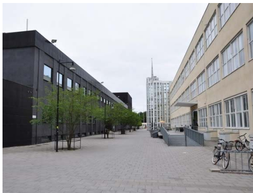
Konstfacksgången mellan Designens hus lågdel och fabriksanläggningens karakteristiska trapphus och entréparti
