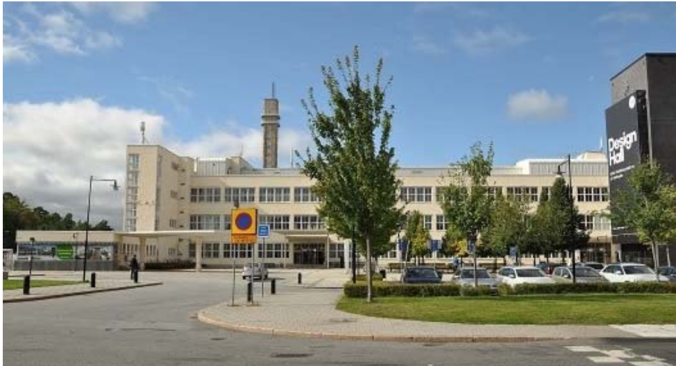
LM Ericssons fabriksanläggning med Designens hus till höger i bild.
