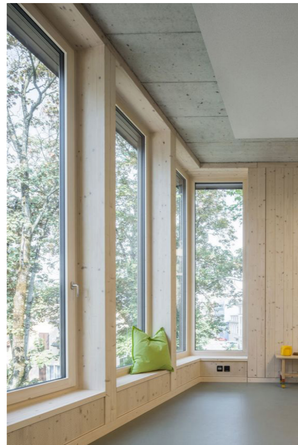
Förskola, Zurich, Rossbauer Architekten. Barnanpassade fönsternischer, att sitta i. Inga radiatorer sitter i vägen - golvvärme.
