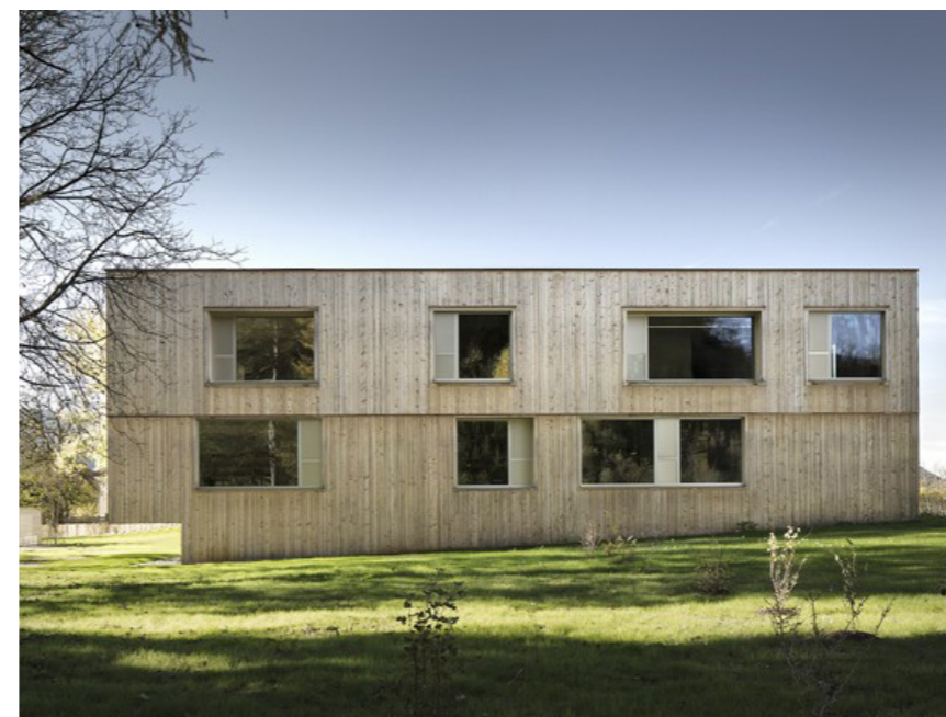
Förskola Schlins, Bernardo Bader Architekten. Fasader av träpanel.
