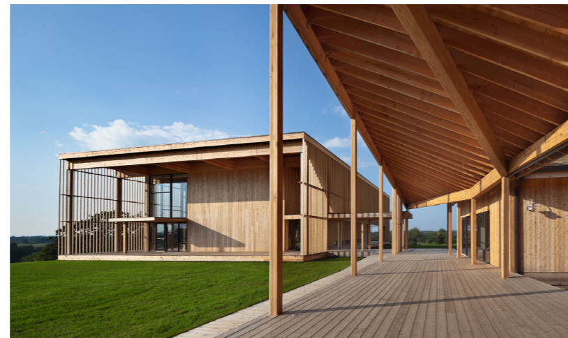
Buddistcenter Claverack NY, Won Architects. Detaljer och synliga konstruktioner i trä.
