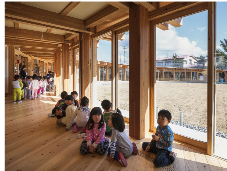
Förskola Nara, Tezuka Architects. Låga bröstningar ger fin kontakt med uterummet.
