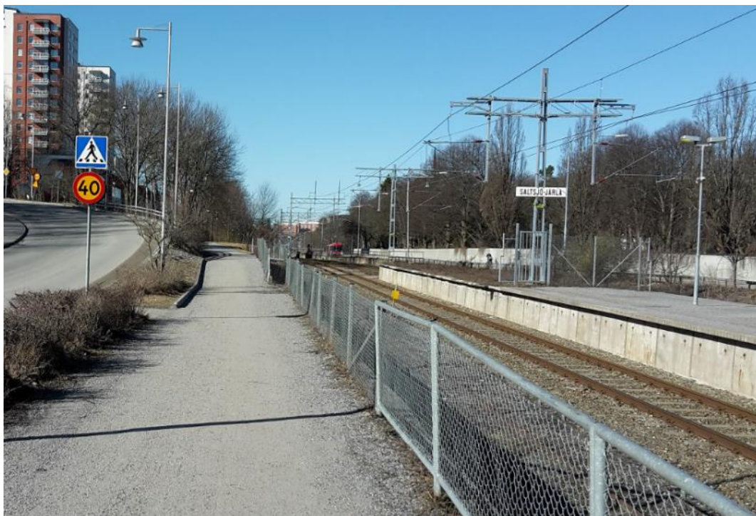
Figur 29. Passage under järnvägen vid station Saltsjö-Järla, ledningsdragningsen fortsätter sedan längs med gång- och cykelbanan.
