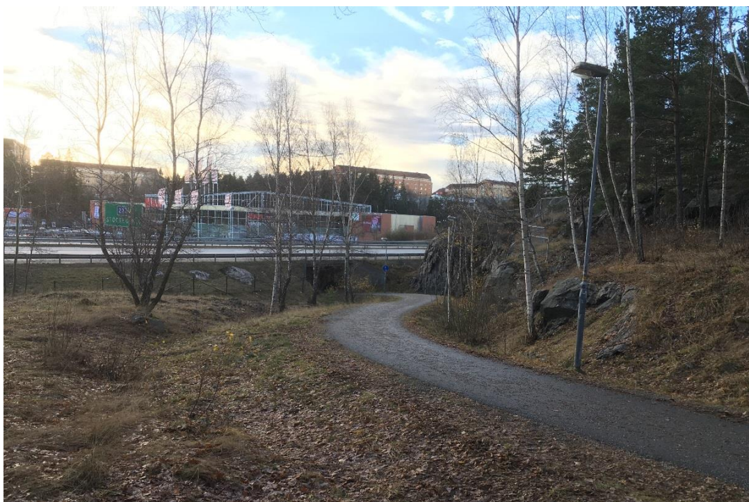
Figur 33. Gång- och cykeltunnel under Värmdöleden.
