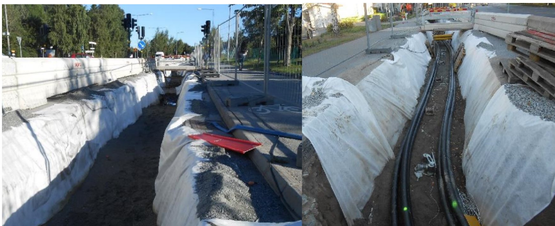
Figur 6. Exempel på markkabelschakt i stadsmiljö.
