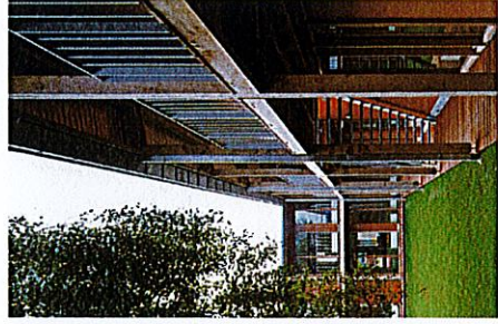
Vårdboende, Mecanoo Architects. Innergård med träbalkonger.
