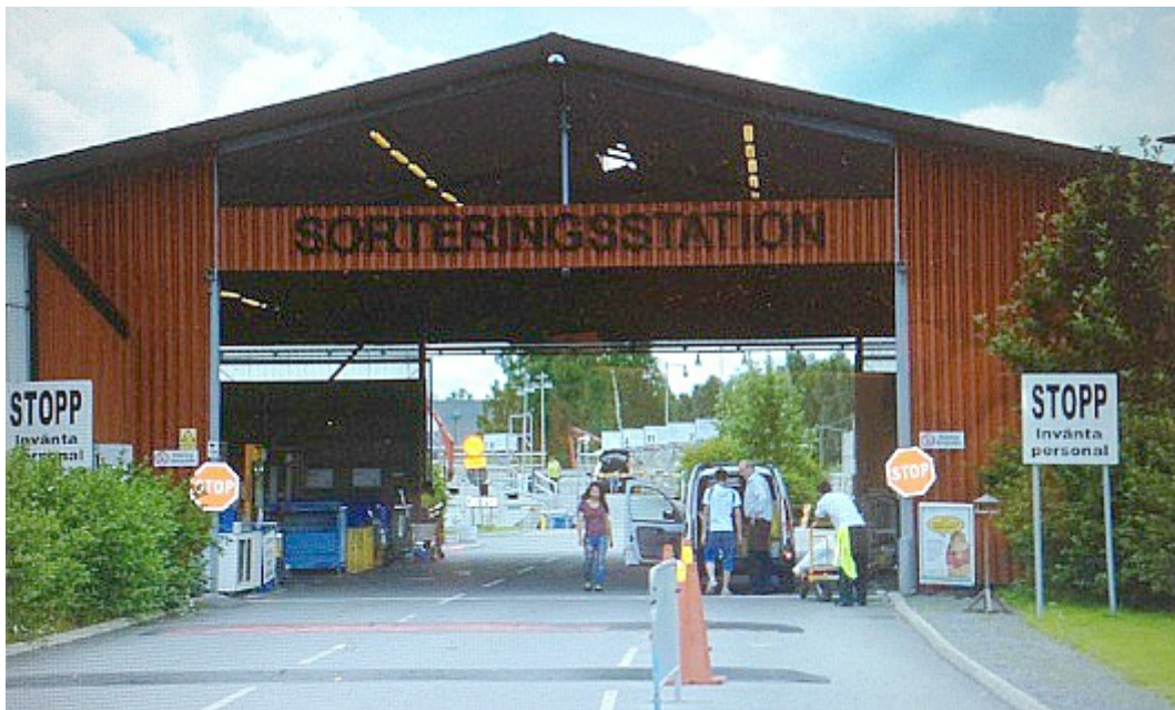
Fig 18. Kretsloppsparken Alelyckan, Göteborg, mottagningshallen Referens: www.mittsundbyberg.se
