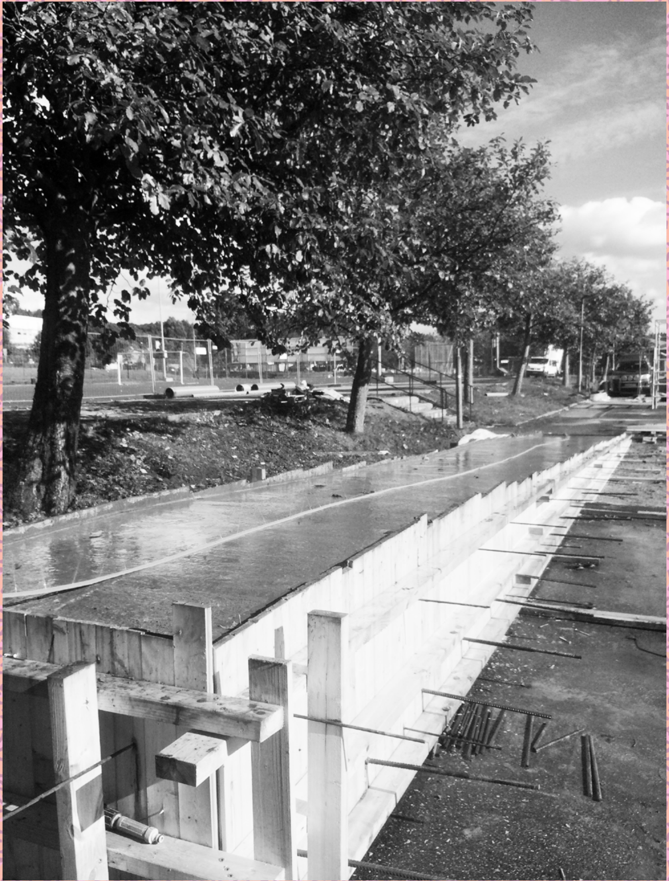
Foto: Malin Croner. Byggnation av Folkhälsoparken i Alby
