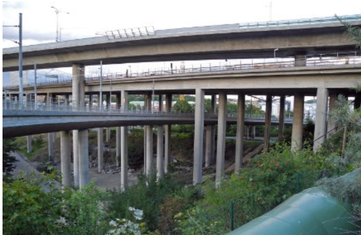
En del av området under broarna sett från Skanskvarn. Foto: Rickard Sundin 2014.
