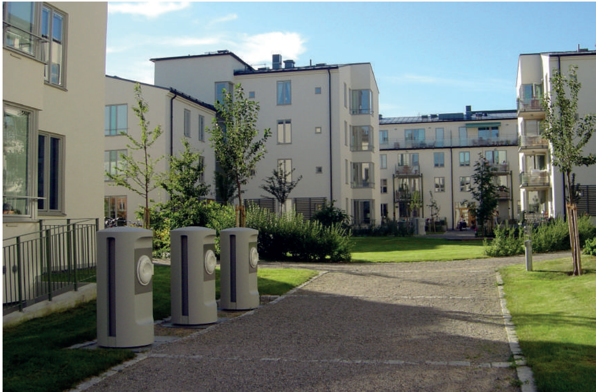
Sopsugsinkast i Barnängen, Norra Hammarby.
