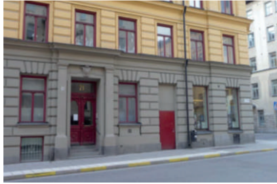
Bilden visar hur en fasad kan förändras om ett fönster ersätts av dörren till ett soprum. (Fotomontage)
