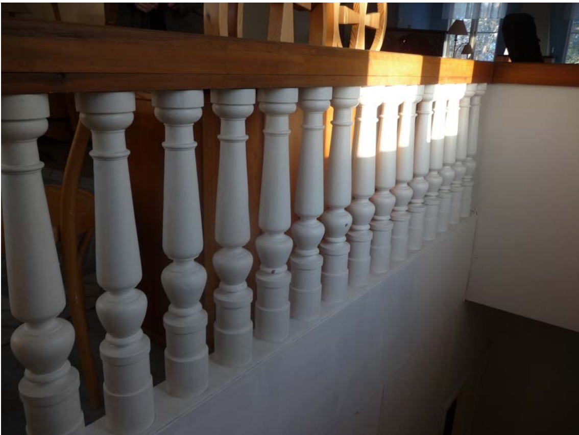
Balusterräcke vid trappa till läktarvåning/ungdomsavdelning
