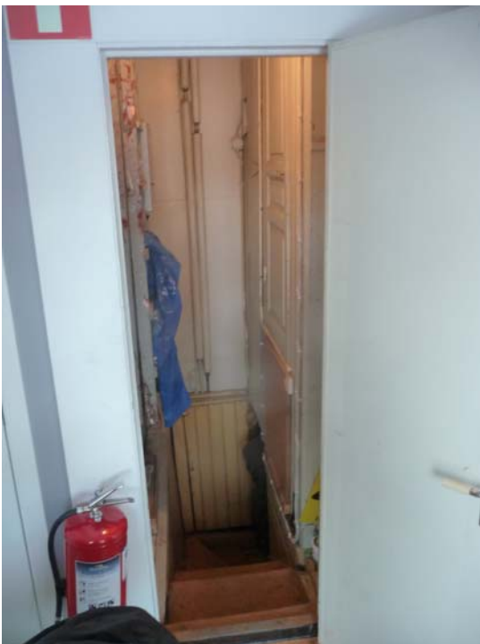
Nedgång till "Värmekammaren" ytskikt från 1901 i pärlspont och spegeldörrar
