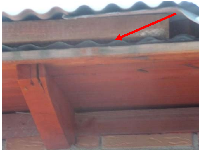
Det gamla sinuskorruerade plåttaket ligger kvar under det senare påbyggda plåttaket av samma typ.
