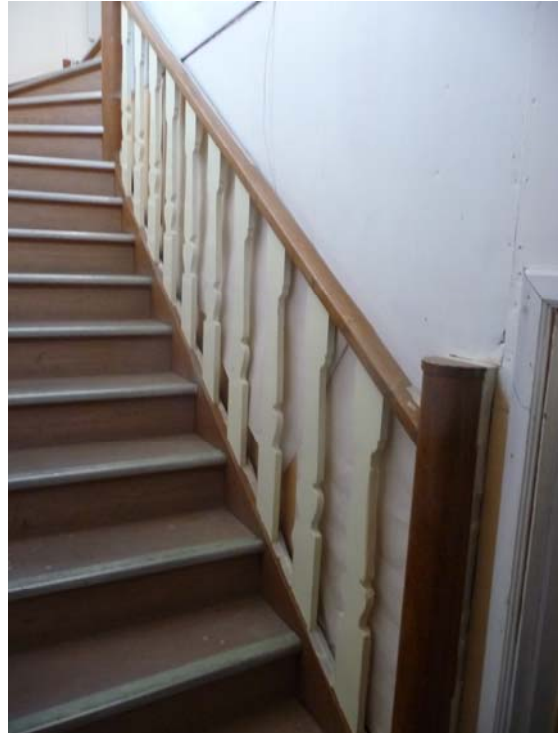
Trappa till f.d. läktare, ungdomsavdelningen
