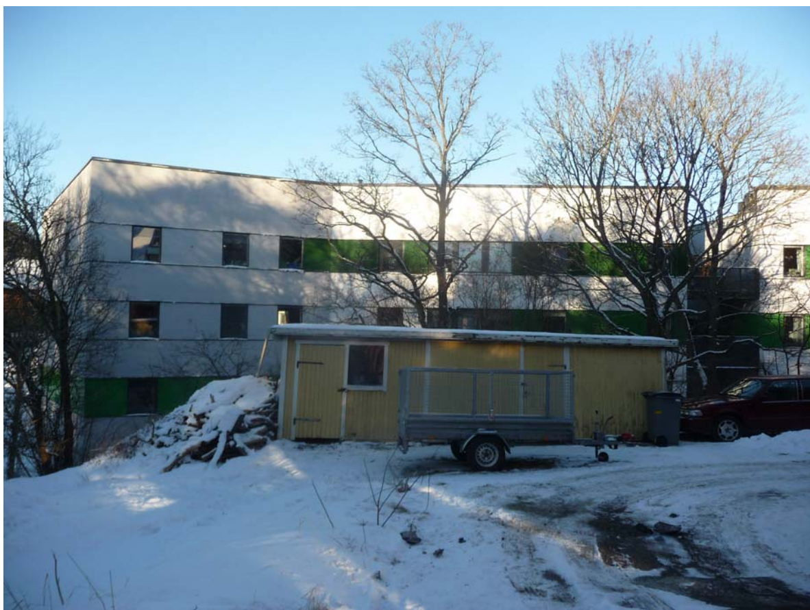
Nybyggt bostadshus som närmsta grannhus i skarp kontrast till omgivande bebyggelse. Det gula förrådet tillhör fastigheten Ösby 1:17.
