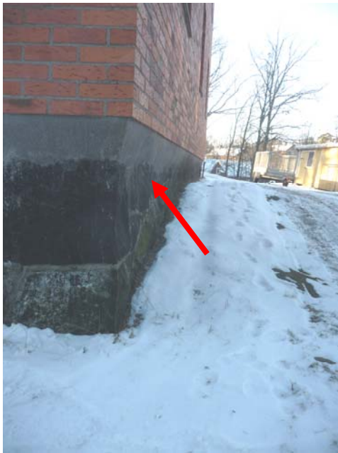
Den ursprungliga stensockeln med betong-Fasning som upptar livskillnanden till teglet
