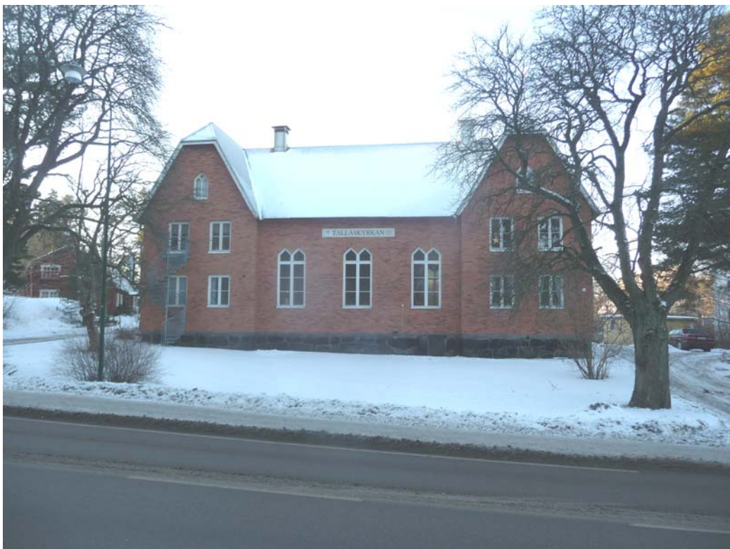
Tallåskyrkans fasad mot Skärgårdsvägen. Det centriskt placerade tornet är avlägsnat och ersatt av en tillkommande ventilationsskorsten.
