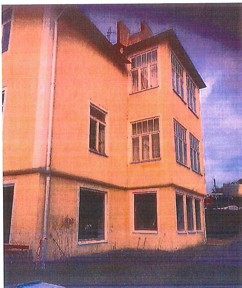
Bostadsbyggnaden idag, vy från söder.
