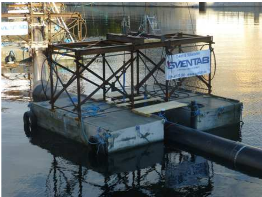
Figur 10. Exempel på sänkning av dykarledning.
