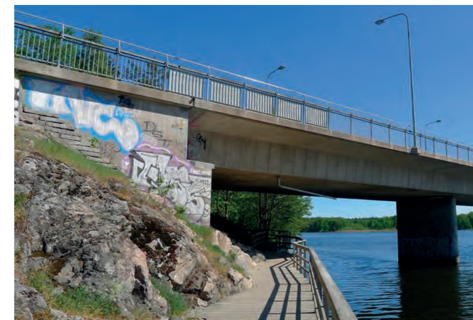
Foto från vy 3, befintliga gångbana under bron.
