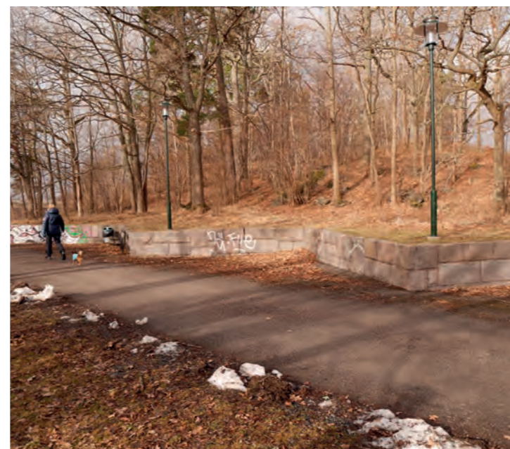
Foto från vy 1, befintlig mur.
