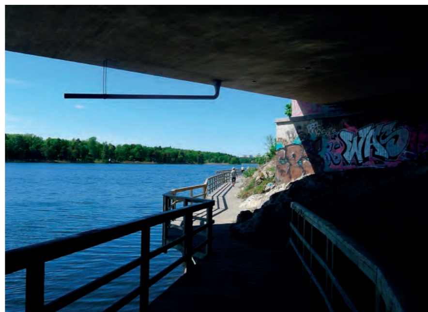
Foto från vy 2, gångbana samt graffiti under bron.
