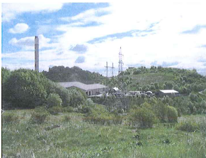
Högdalstopparna omsluter verksamhetsområdet. (Sweco) Högdalstopparna är en del av Stockholms stadsbyggnadshistoria. De kom till under 1960-talet då staden behövde en plats för att
