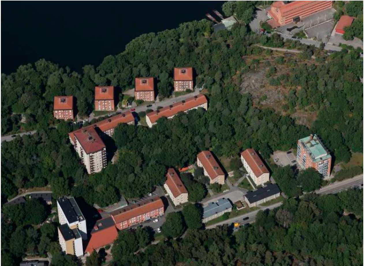
Bild 3. Bottenstocken 11, Gröndal med befintliga 2 modullängor framför lamellhusen, längs Gröndalsvägen
