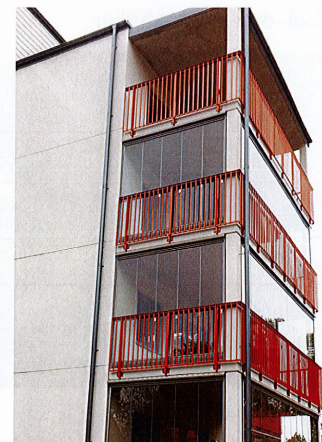
Referensbild över räcke och balkonginglasning. Kulör överensstämmer ej med kulören i projektet.
