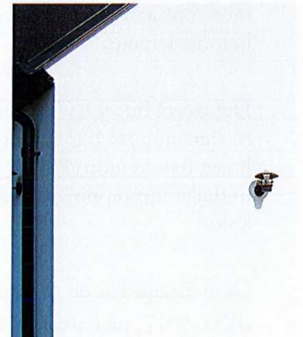
Referensbild över putsad fasad
