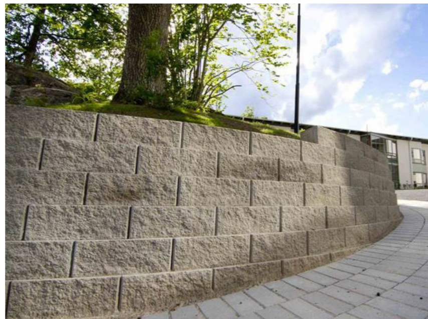
Referensbild över släntstöd med knäckt framkant, Bender Megasmart eller likv.
