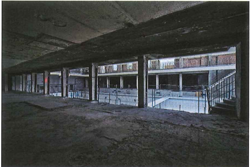
Badet sett från tidigare omklädningsrummet (utrivet). Foto: Lennart Johansson
