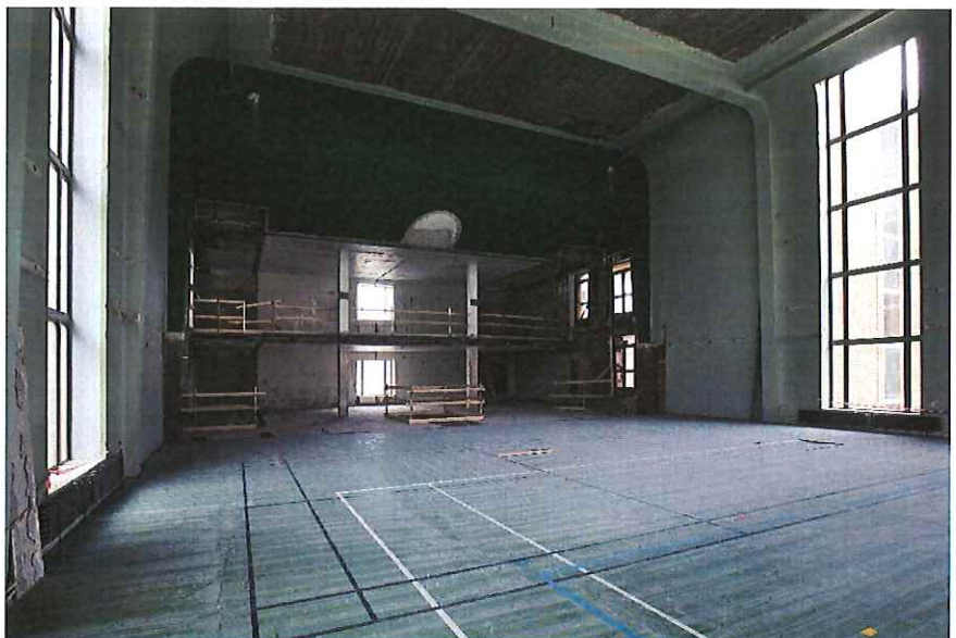
Idrottshallen mot tidigare läktare och omklädningsrum (rivna). Foto: Lennart Johansson
