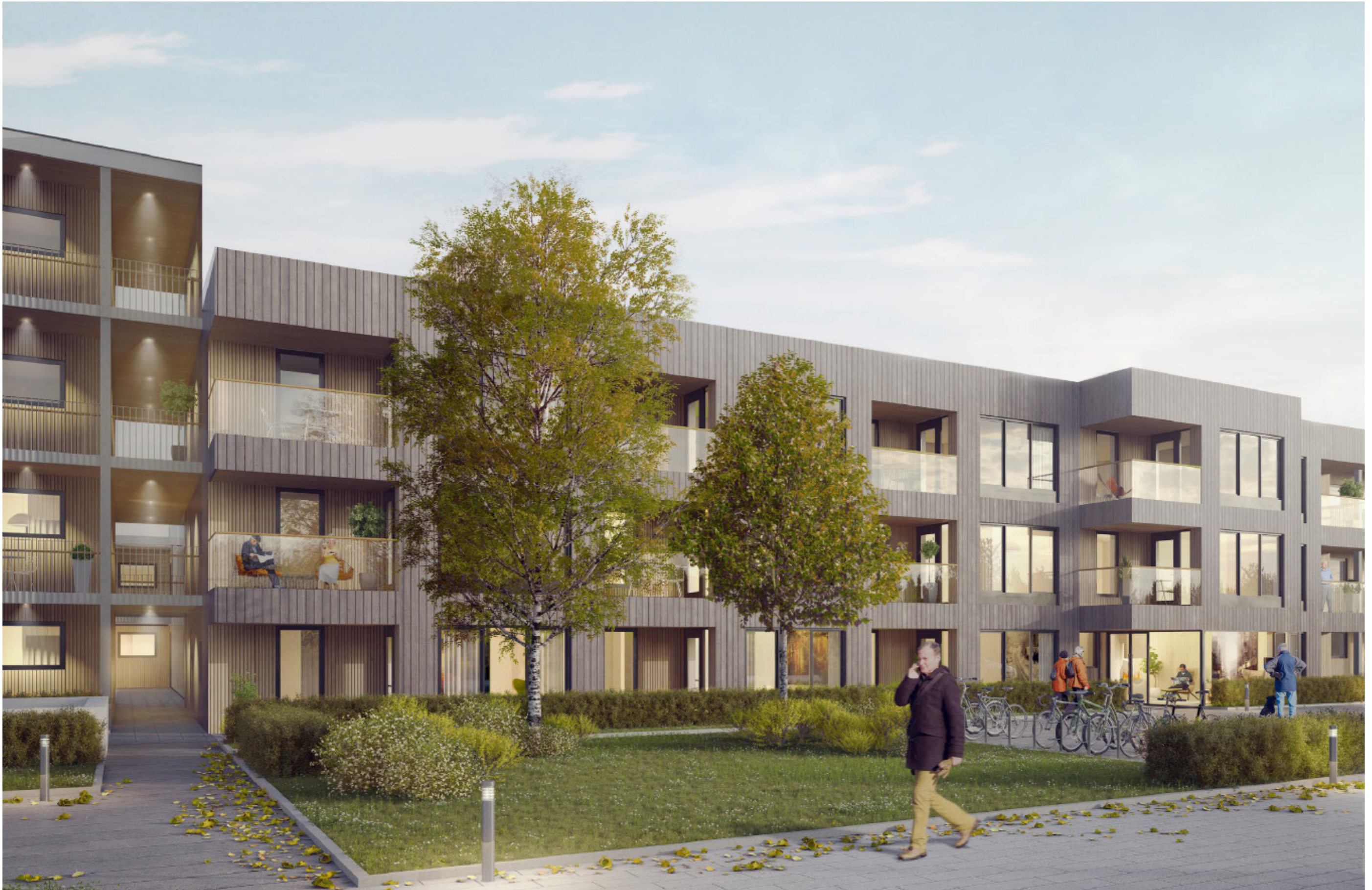
Referensbild fasaden mot Apelvägen
