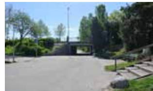
3. Gång- och cykeltunnel under Bollmoravägen
