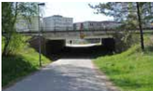
1. Gång- och cykeltunnel under Tyresövägen
