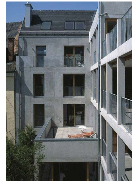
Kort loftgång med ljusgrå fasad i vinkel, samt svart tak. Kraus Schauenberg Arch.
