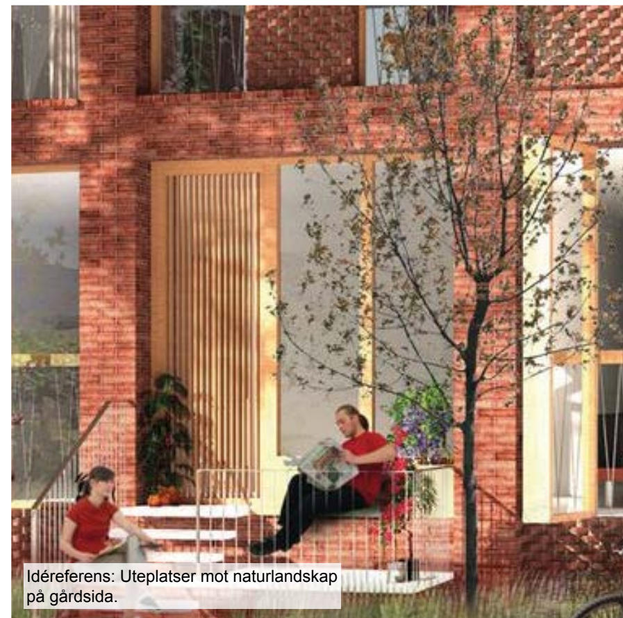
Olika behandling av tegel i olika fasaddelar
