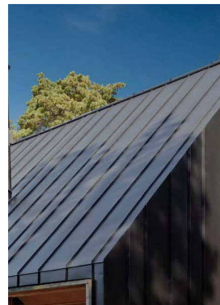
Tak i svart plåt.
