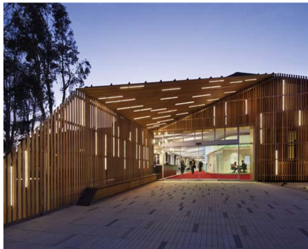
Medvetet utförd belysning av fasad och mark skapar en trygg och inbjudande miljö.
