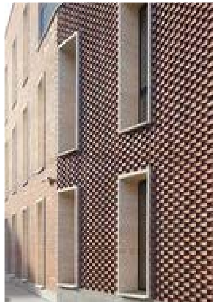
Exempel på tegelbyggnad i vinkel och vad det betyder för ljus- och skuggbild.
