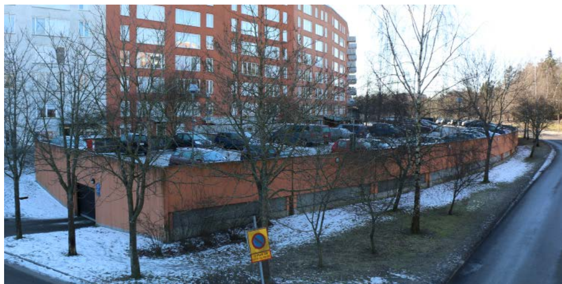
Befintlig garagebyggnad i betong blåstras så att betongens yta och kulör framträder.
