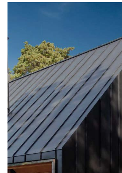
Tak i svart plåt.
