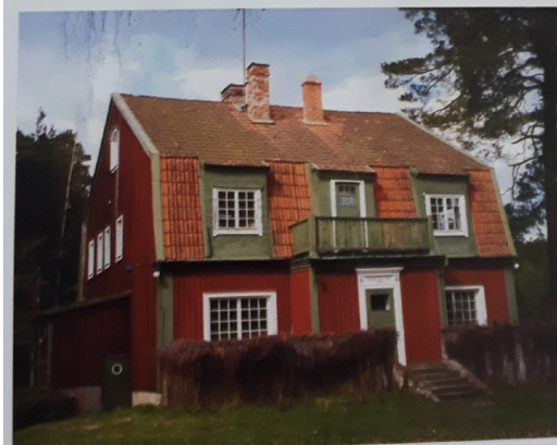
Susegårda från 1905, beläget cirka 1 km öster om bykärnan. En tung, kompakt byggnadsvolym med brutet tak – nationalromantisk stil med herrgårdsanknytning. Foto författaren 1999.
