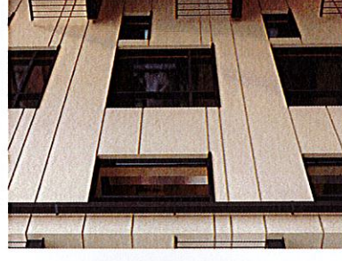
Bild över raster i betongfasad
