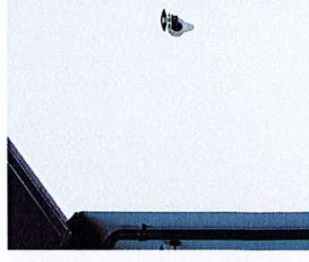
Referensbild över putsad fasad
