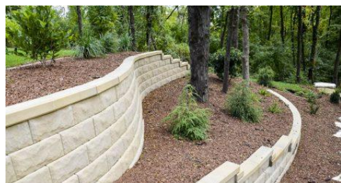
av fasader och markplanering
