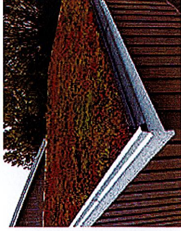
Exempel sedumtak på komplementbyggnader
