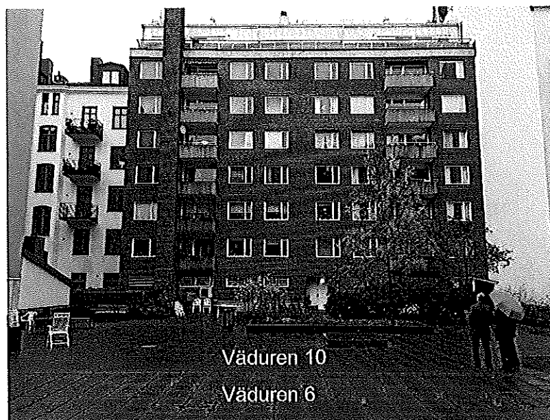
Fotot visar gården och gathuset på fastigheten Väduren 10 sett från grannfastigheten Väduren 6. Den streckade linjen markerar ungefärlig fastighetsgräns.
