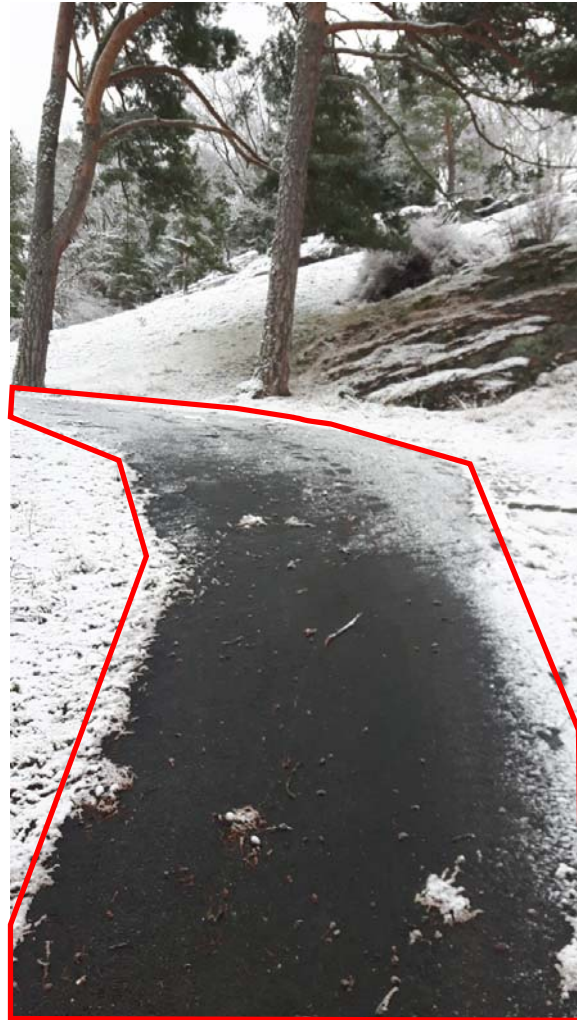
Bild 7. Del av asfalterad väg, markerat med rött, som enligt föreläggande ska tas bort.
