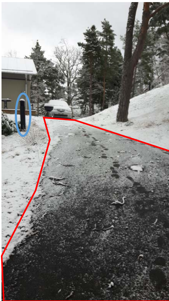
Bild 8. Del av asfalterad väg, markerat med rött, som enligt föreläggande ska tas bort. Lyktstolpe markerad med blått som enligt föreläggande ska tas bort.
