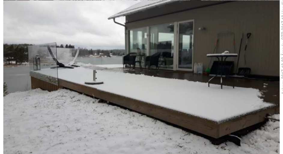
Bild 13. Tillbyggd altan, markerat med rött, som enligt föreläggande ska tas bort. Bilder till höger visar altanen från vattnet och från land.
