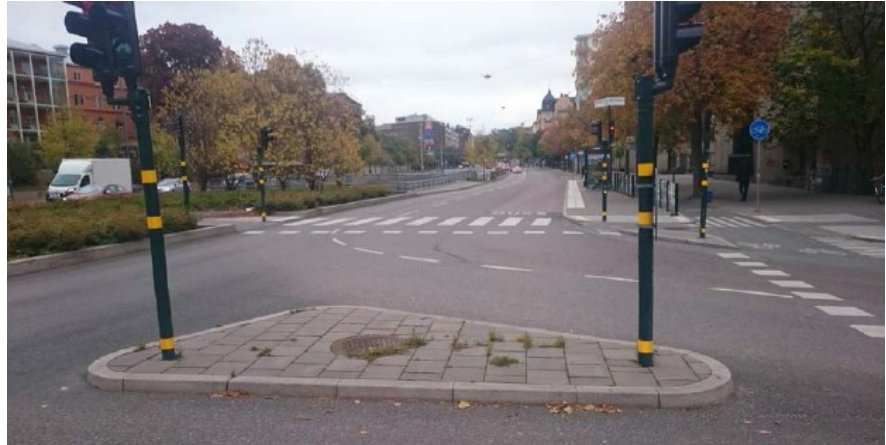
Figur 5. Korsningen Drottningholmsvägen/Mariebergsgatan med hållplats Mariebergsgatan i bakgrunden.
