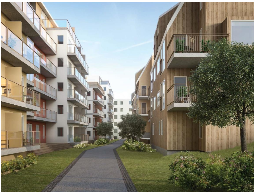
Vy över gårdsrum mot öster. Flerbostadshus till vänster och stadsvillor till höger. Bild Reierstam arkitektur
