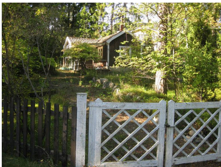
Befintlig huvudbyggnad på Gullvivan 4
