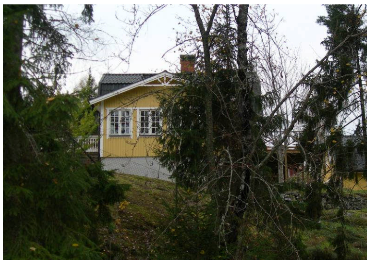
Befintlig huvudbyggnad på Gullvivan 5
