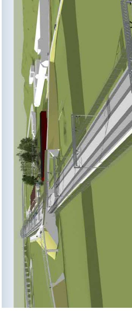
Figur 15. Illustration av en möjlig lösning för den planskilda korsningen vid Sulkyvägen i form av en L-lösning.
