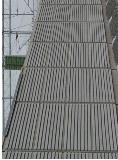
Figur 25. Utsida på bullerskyddsskärm från tidigare etapp utmed Mälaren (Barkarby-Kallhäll)
