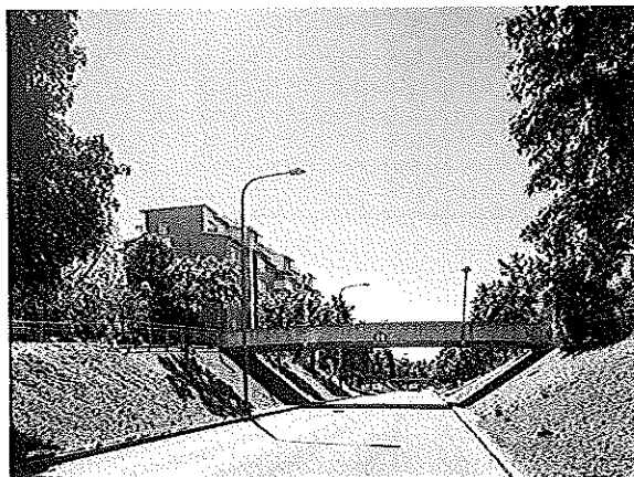
Rinkebystråket före och efter ombyggnationen
