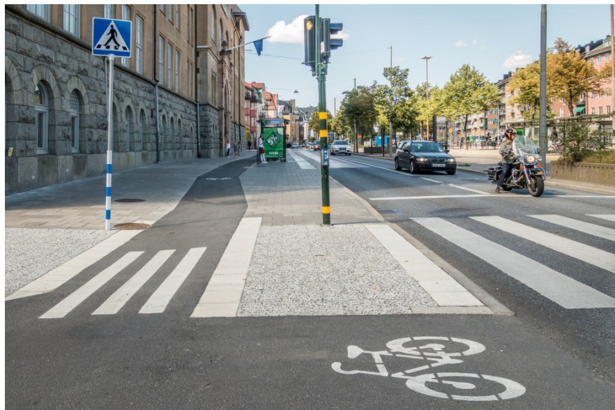
Bild 4: Hållplatsläget på Valhallavägens södra sida efter ombyggnad
