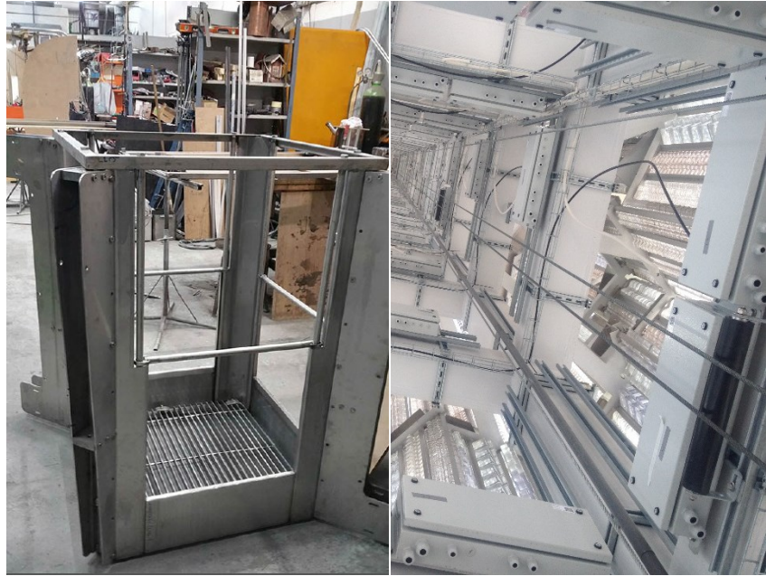
Vänster arbetsplattform, höger påbörjat belysningsmontage
